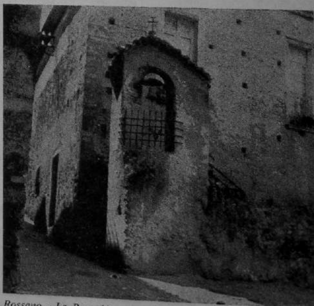
Rossano - La Panaghia: piliero costruito durante i restauri del 1933-34, rimosso con i lavori di sistemazione del 1963.
