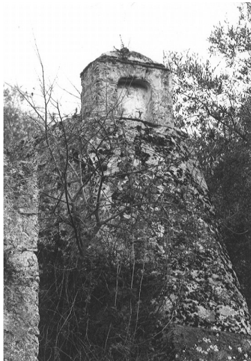
Torre di mulino ad acqua sul Celadi (n. 6 della mappa) distrutto nel 1980.
