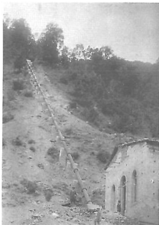
1925: la Centrale idroelettrica "Sullacca", lungo il Trionto; di proprietà del sig. Via di Longobucco, fu acquistata e ingrandita dai F.lli Smurra, i quali l'ampliarono sfruttando altri 2 "salti" (Centrali di "Puntadura" e "Castellaccio").
