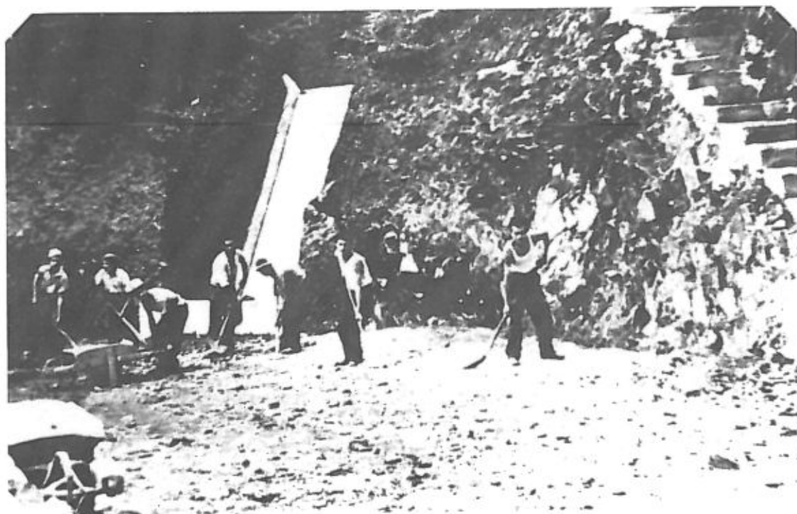
La prima Amm.ne Com.le del dopoguerra iniziò la costruzione della strada per la montagna, al fine di dar lavoro ai numerosi reduci disoccupati. Nel 1953, esauriti i fondi, i Sindacati vollero che i cantieri restassero aperti, attuando una nuova forma di lotta: lo sciopero alla rovescia.
