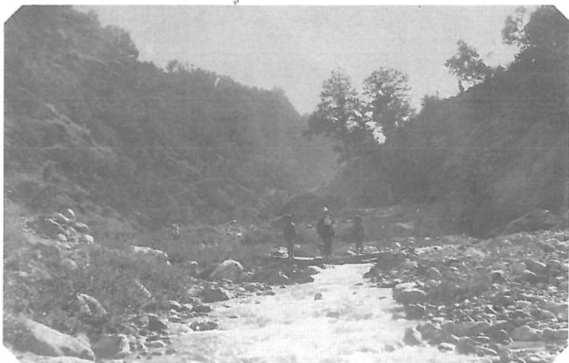
1903: ponticello (= asse di legno) sul torrente Colognati.
