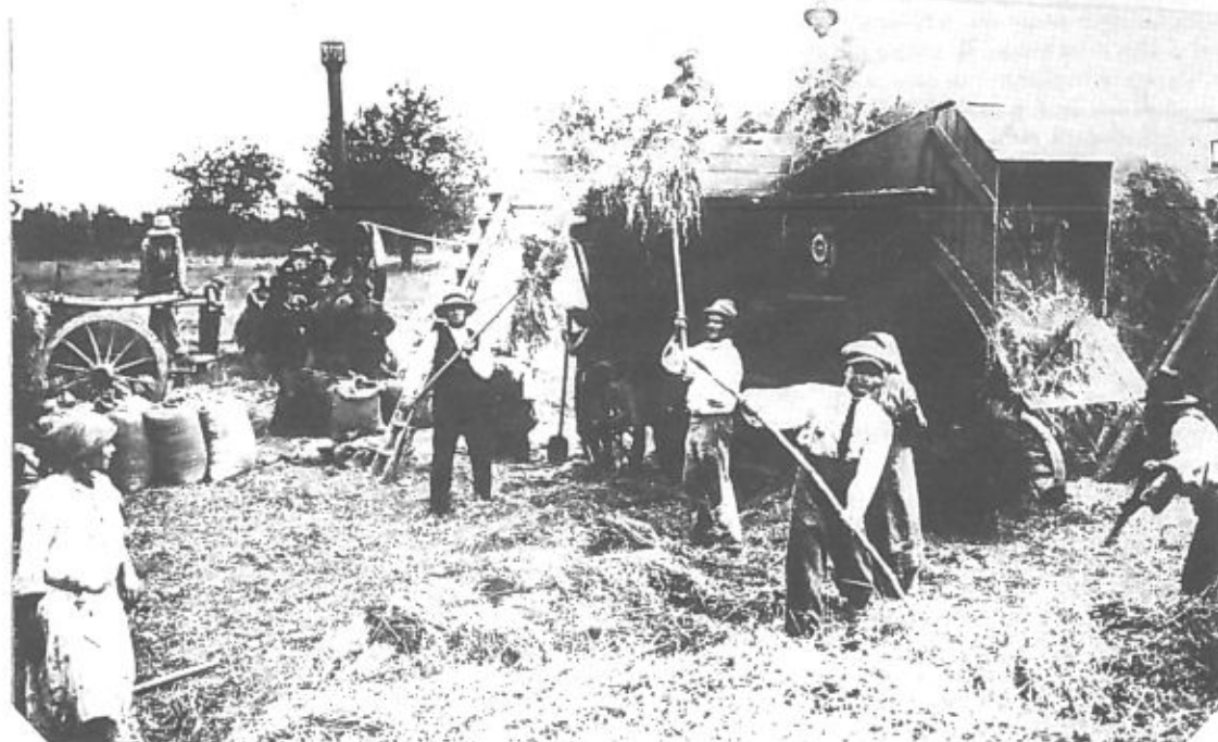
1924: trebbiatura del grano in contrada Amarelli; la foto mostra una locomobile a vapore alimentata con i fessidui stessi della trebbiatura.
