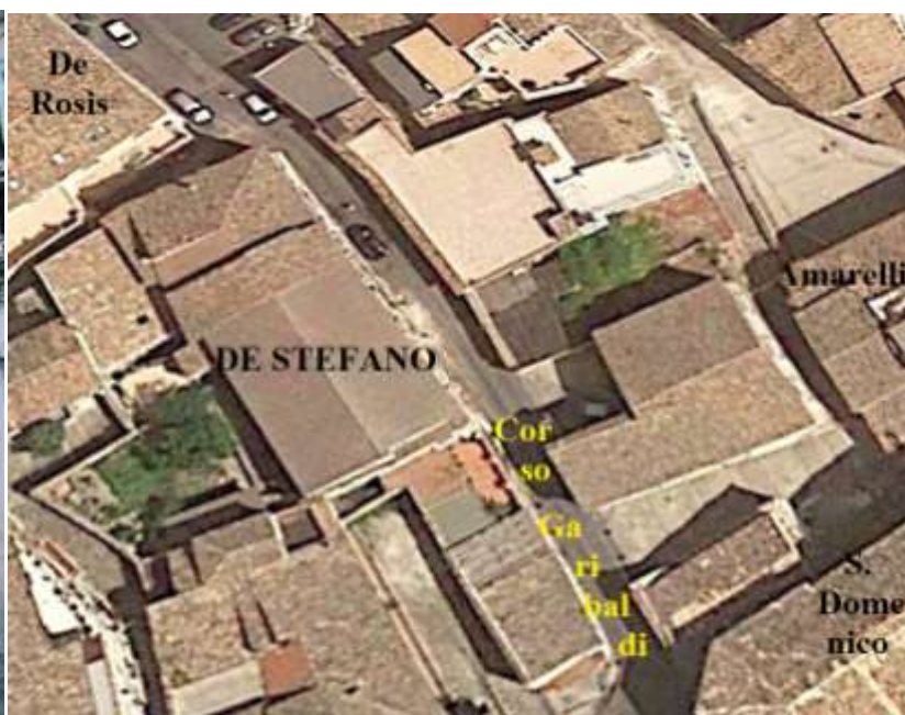
I dintorni del palazzo, Google Earth
