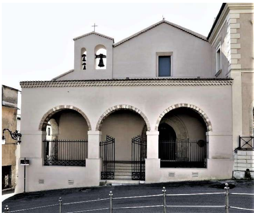
Nel portico antistante si tenevano le riunioni del Sedile, almeno finché fu deciso di spostarle in un locale adiacente al chiostro dedicato all'Immacolata Concezione
