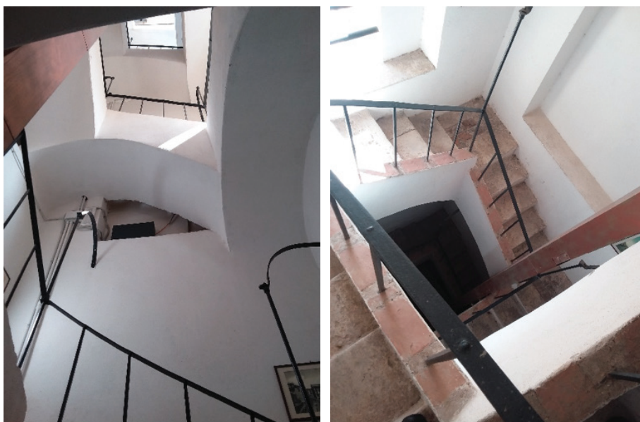
Figg. 50, 51. Le rampe delle scale che portano alla sommità della torre.
