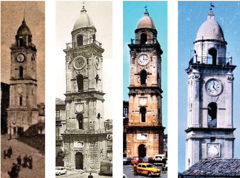
Figg. 57, 58, 59, 60. Le immagini documentano le condizioni di degrado della Torre già a partire dalla fine dell'800.
