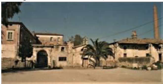
Casino, cappella e resti fabbrica liquirizia
