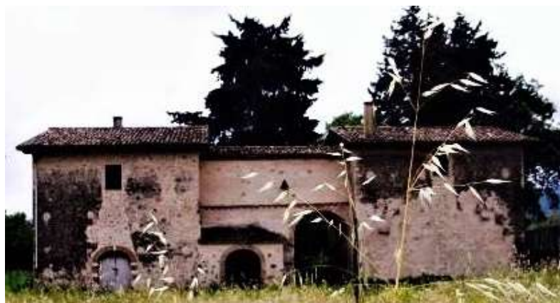
Foto del 1989: il piccolo edificio nel campeggio e la vicina "porta del sale"
