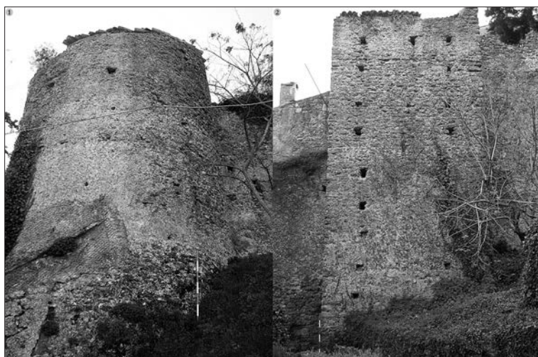
Fig. 11. - Circuito fortificato della fase Sanseverinesca (XIV sec. d.C.): torri di difesa (1: torre circolare; 2: torre rettangolare).
