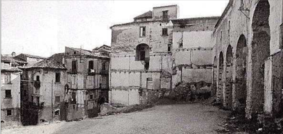
Piazzetta Toscano negli anni '50 del secolo scorso (da Terzi 2014); sotto particolare della superfetazione sullo scavo archeologico di Piazzetta Toscano
