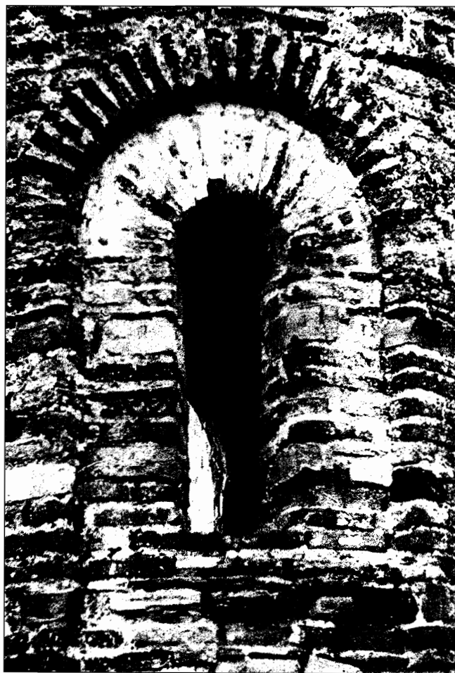
Fig. 21 - Staiti. Santa Maria de Tridetti. L'abside di sinistra. Particolare esterno
