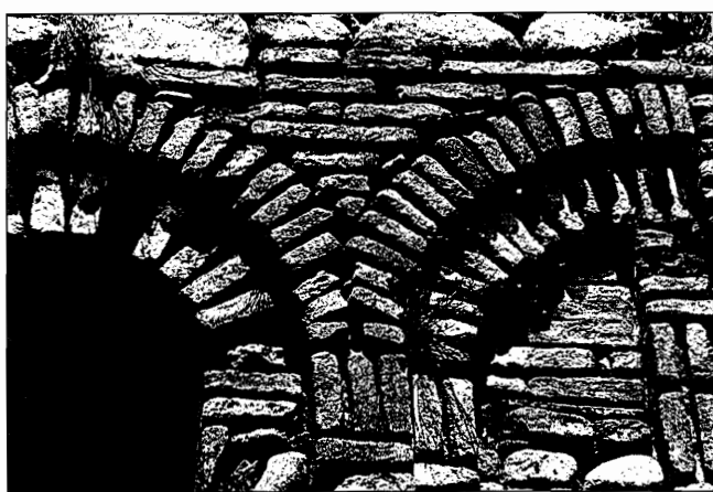
Fig. 10 - San Giovanni Theriste. Fiancata sud. Particolare nella disposizione dei mattoni in arcate e loro piedritti.
