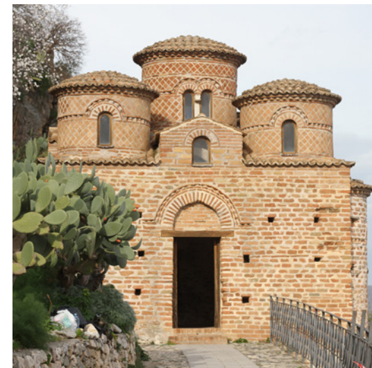
Fig. 1 - Vista del prospetto sud della Cattolica.
